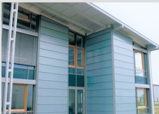
Použití lamel a vlnitých plechů na fasádě.
