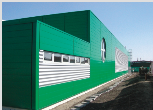
Použití lamel a vlnitých plechů na fasádě.
